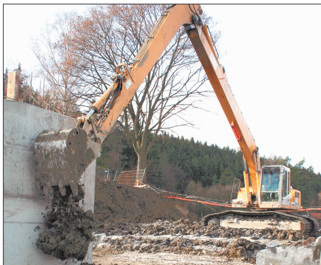
Nová hráz. Vypuštěnému rybníku se momentálně začíná nasypávat nová hráz. Foto Radim Hruška
