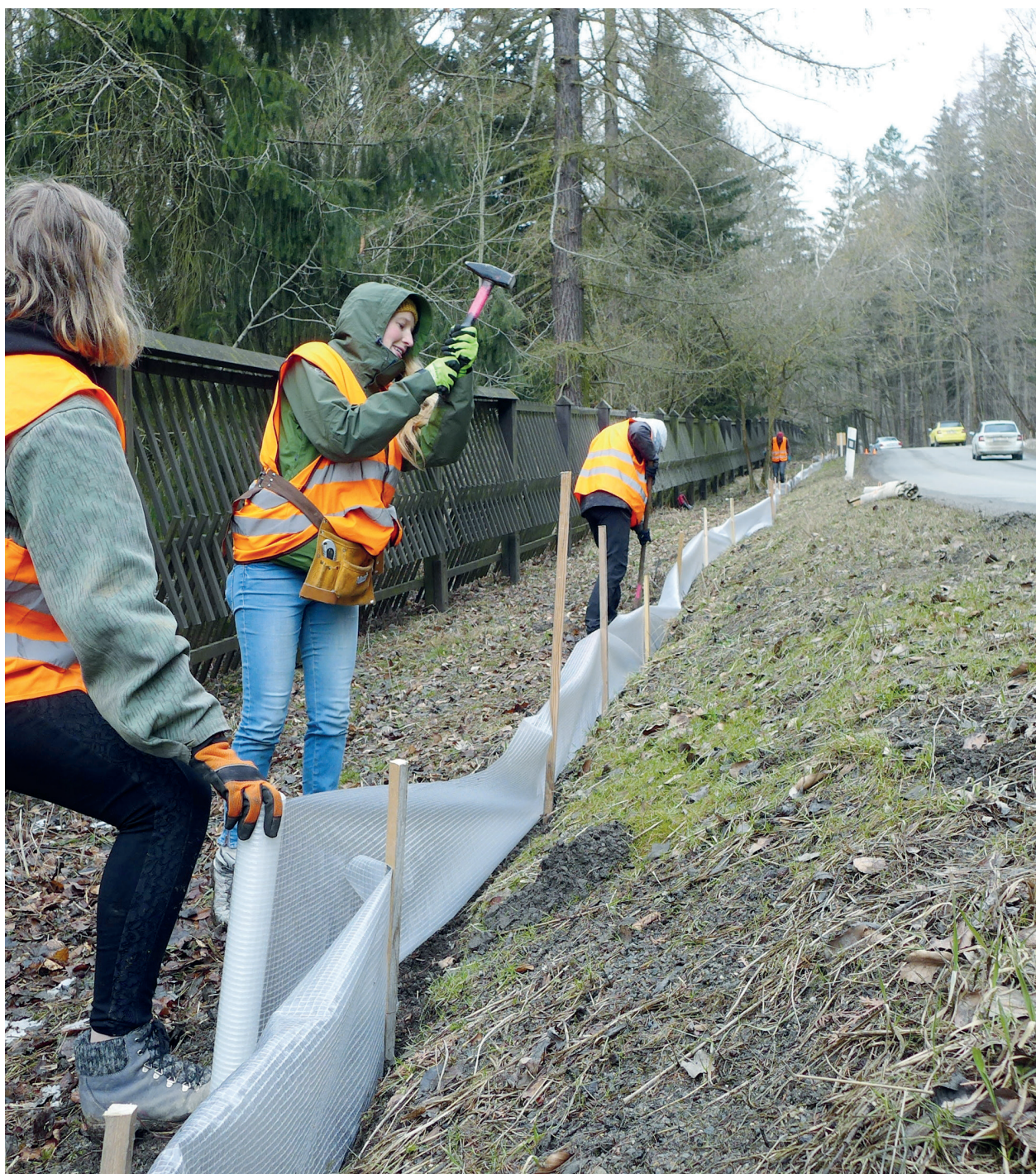
Dobrovolníci postaví 1 460 metrů ochranných bariér. Více na straně 3.
