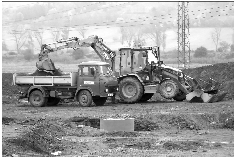
Stavba začala. Na okraji Svitávky počala budovat svůj nový objekt firma CIRTO. Foto Bohumil Hlaváček
