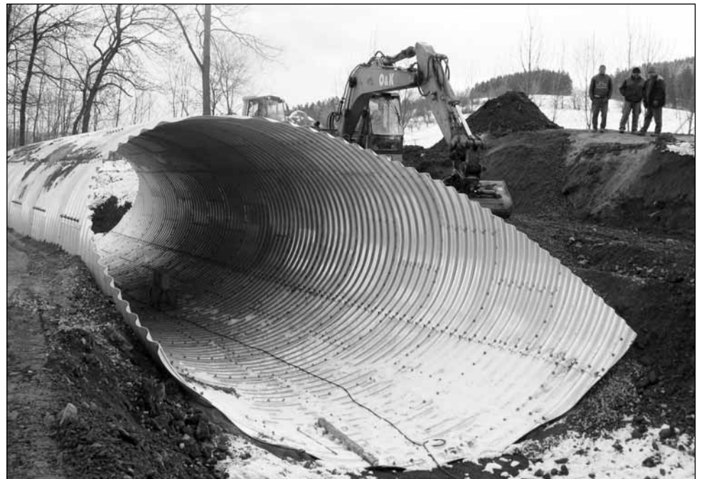
Most. V současné době se pracuje na stavbě nového mostu nedaleko Úsobrna. Foto Radim Hruška
